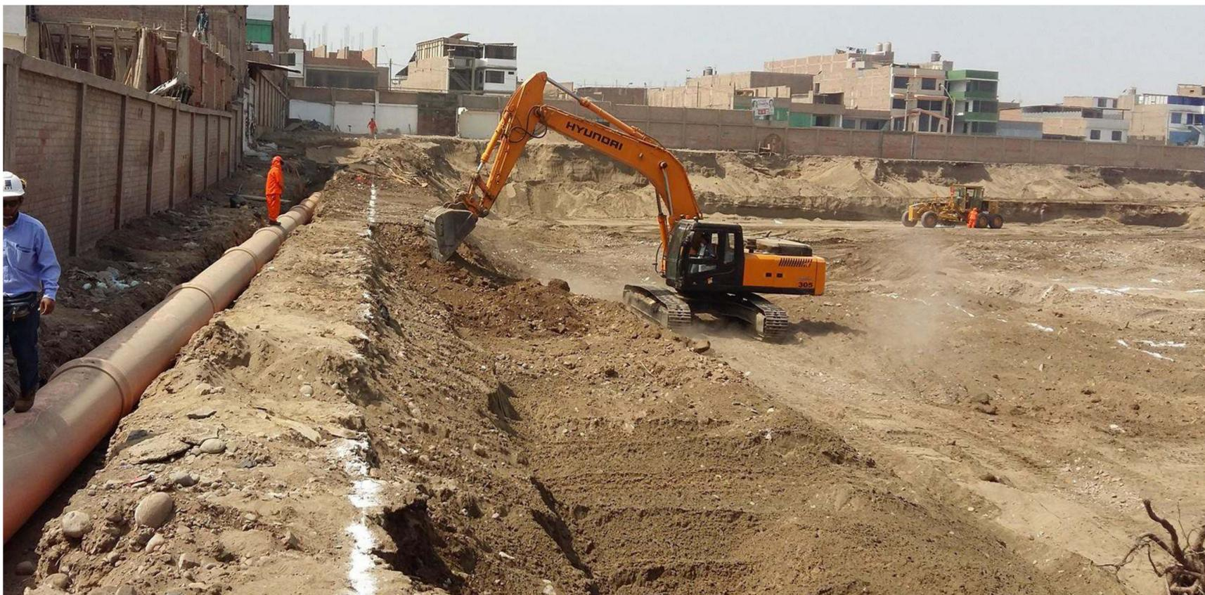
Nivelación del terreno mediante corte y/o rellenos compensados con materiales propios y/o de préstamo. Desarrollado para elevar el nivel de un terreno y así contar con un plano de apoyo que permita el impulso de una construcción. La resistencia de la acumulación de tierra varía de acuerdo al tipo de suelo que se use y de acuerdo al uso que se pretenda dar a la obra.
