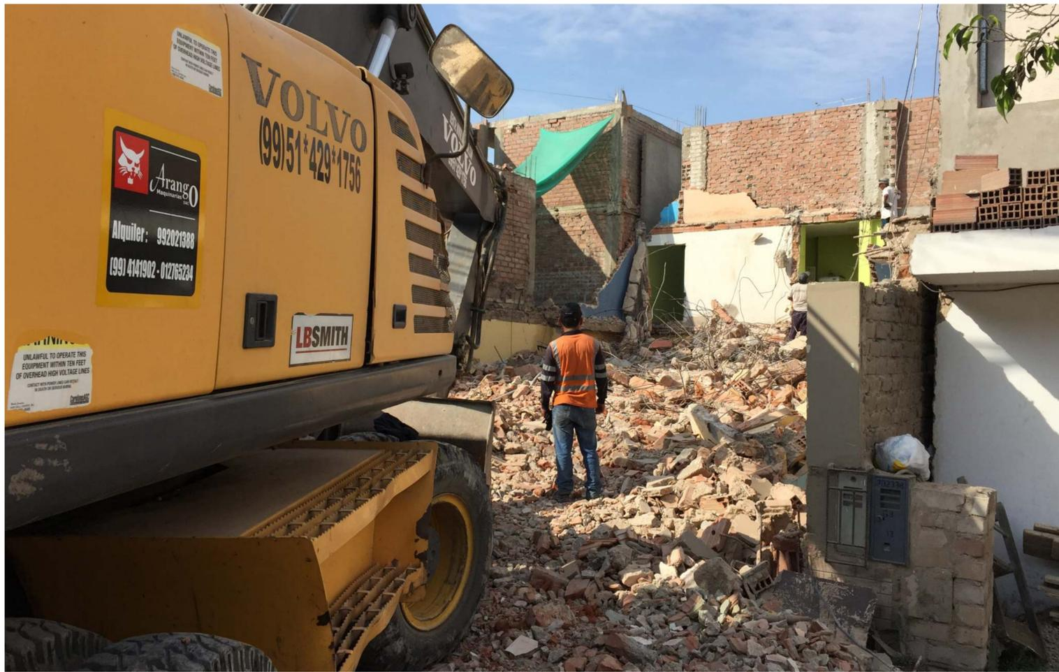
Consiste en la preparación preliminar de un terreno destinado para el desarrollo de un proyecto de construcción. Se realiza combinando métodos mecanizados con trabajo manual y por lo general se trata de volúmenes importantes de material a remover.
