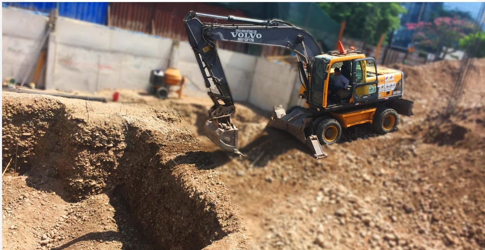
Consiste en la preparación preliminar de un terreno destinado para el desarrollo de un proyecto de construcción. Se realiza combinando métodos mecanizados con trabajo manual y por lo general se trata de volúmenes importantes de material a remover.
